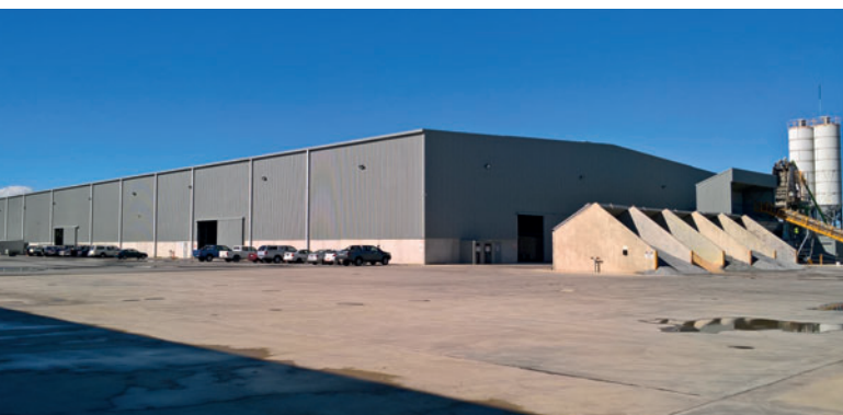
A BGC Precast produz na ultramoderna fábrica em Kwinana painéis de parede e de arquitetura personalizadas e de alta qualidade. (Fotografia: BGC)
